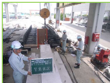
横梁・PC鋼材緊張
