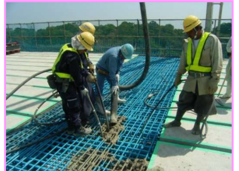
連結工・連結部コンクリート打設
