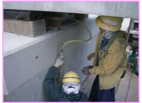
支承工・沓座モルタル打設
