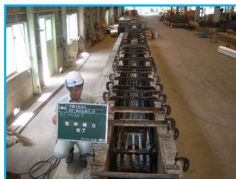
主桁・型枠組立
