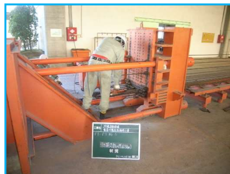
主桁・PC鋼材緊張
