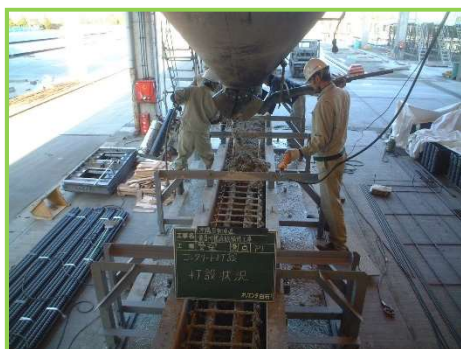
横梁・コンクリート打設
