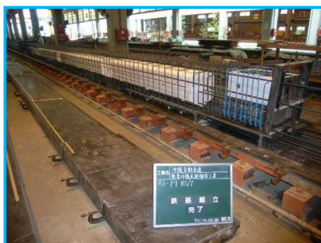
主桁・鉄筋組立
