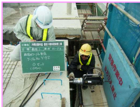
横組み工・PC鋼材緊張
