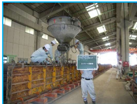
主桁・コンクリート打設
