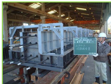
横梁・型枠組立
